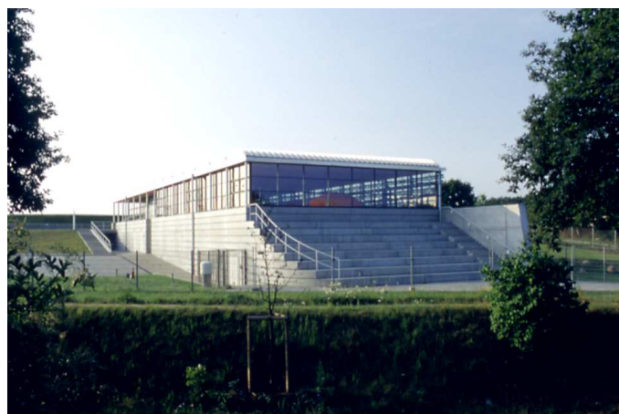
Neubau Wasserwerk Mühlenscharn, Schwerin - Landesbaupreis M-V 2000, 2. Rang
