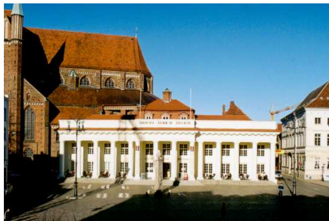
Sanierung und Umbau Säulengebäude, Schwerin
